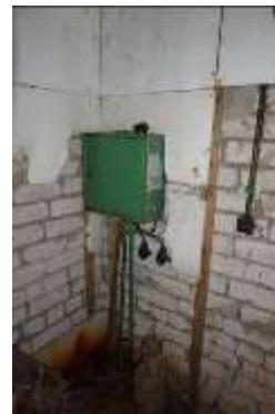
Būve (sūkņu stacija) ar kadastra apzīmējumu 9813 005 0110 001
