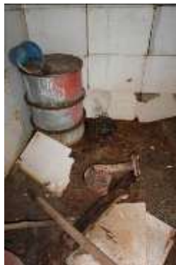
Būve (sūkņu stacija) ar kadastra apzīmējumu 9813 005 0110 001
