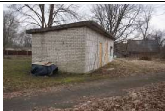
Būve (noliktava) ar kadastra apzīmējumu 9813 005 0101 002
