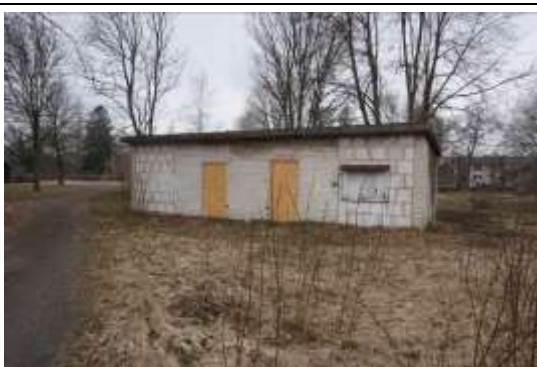
Būve (noliktava) ar kadastra apzīmējumu 9813 005 0101 002
