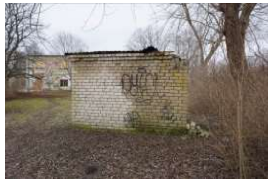
Būve (sūkņu stacija) ar kadastra apzīmējumu 9813 005 0110 001
