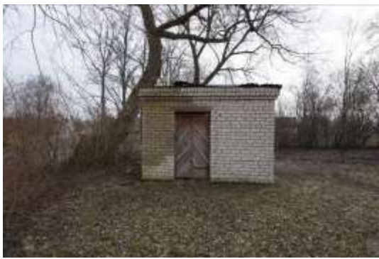
Būve (sūkņu stacija) ar kadastra apzīmējumu 9813 005 0110 001
